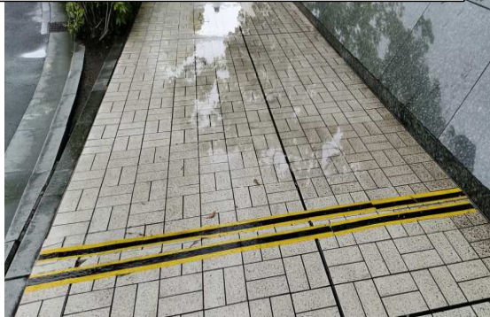
⑧鎌倉芸術館前歩道→黄色テープの所路面にひび→路面の高低差で水たまり発生
